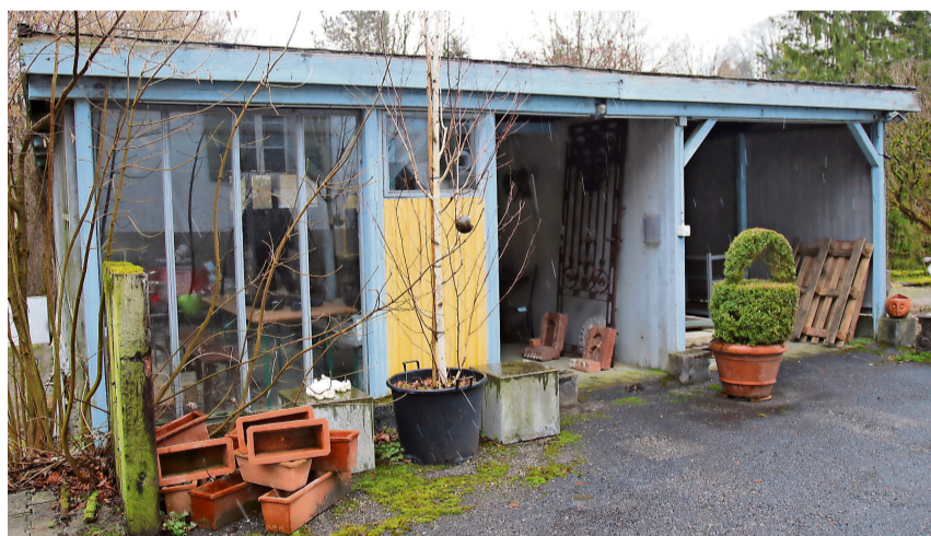
Dieser alte Schuppen wird renoviert und als Katzenhaus umgenutzt. rfb
